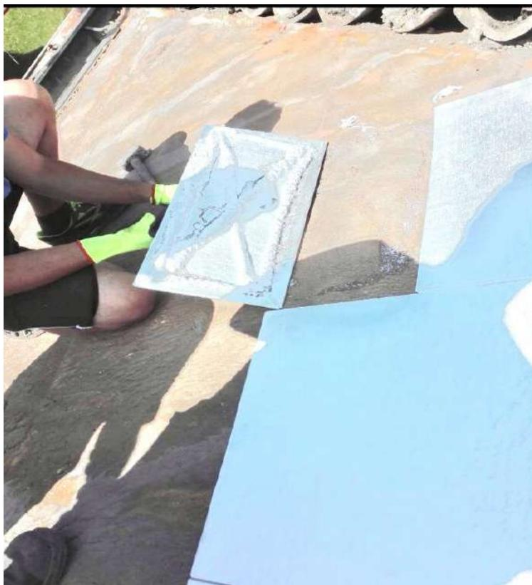
Sopra al pannello CZ, nastrare le fughe/giunti dei pannelli CZ ed il perimetro della copertura con il nastro argentato ISOL-TAPE . Impermeabilizzare a rullo, in due mani incrociate (o a spatola), la guaina liquida monocomponente , **ISOL-LAST 83** , dall'incredibile elasticità, capacità impermeabilizzante e riflettanza dei raggi UV .
