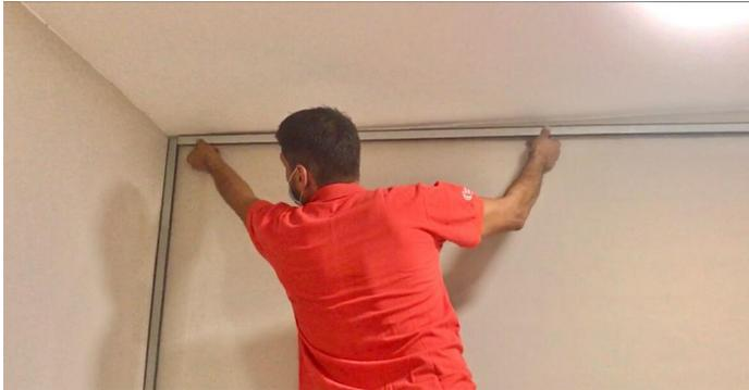
Fije la barra superior al techo, con fijaciones adecuadas al soporte, a una distancia máxima de 50 cm .
