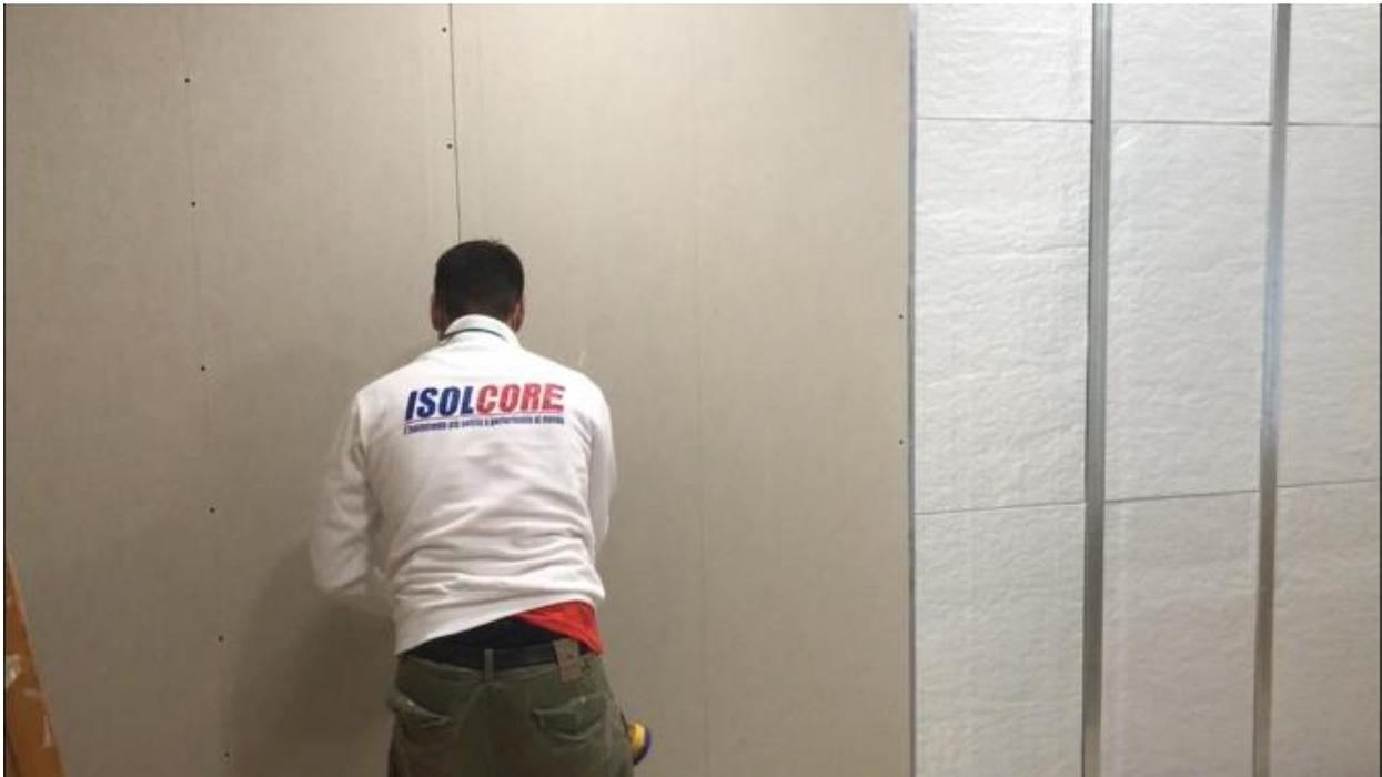
Ajuste la punta del destornillador de modo que los tornillos queden a la profundidad correcta, con la cabeza perfectamente enrasada con el revestimiento de la losa. Los tornillos deben colocarse a 1 cm aproximadamente del borde longitudinal de la losa y a 1,5 cm aproximadamente del borde anterior.
