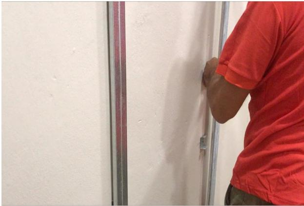
*Nota: Si es necesario tender conductos, utilice montantes especiales del grosor necesario para pasar las instalaciones. . Si la pared es alta y es necesario unir perfiles, realice un solape.*
