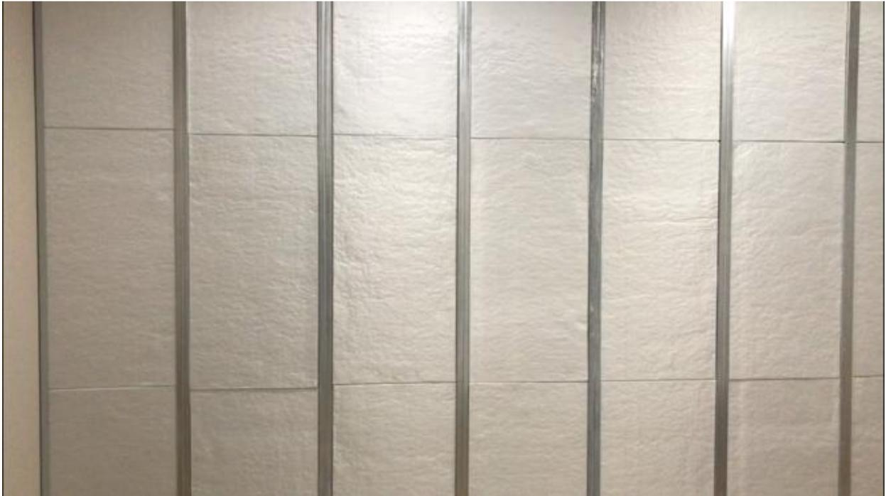
Atención: aplique una ligera presión entre panel y panel para eliminar cualquier junta. Las juntas pueden sellarse encintándolas con cinta adhesiva plateada tipo 'americana' ISOL-TAPE.
