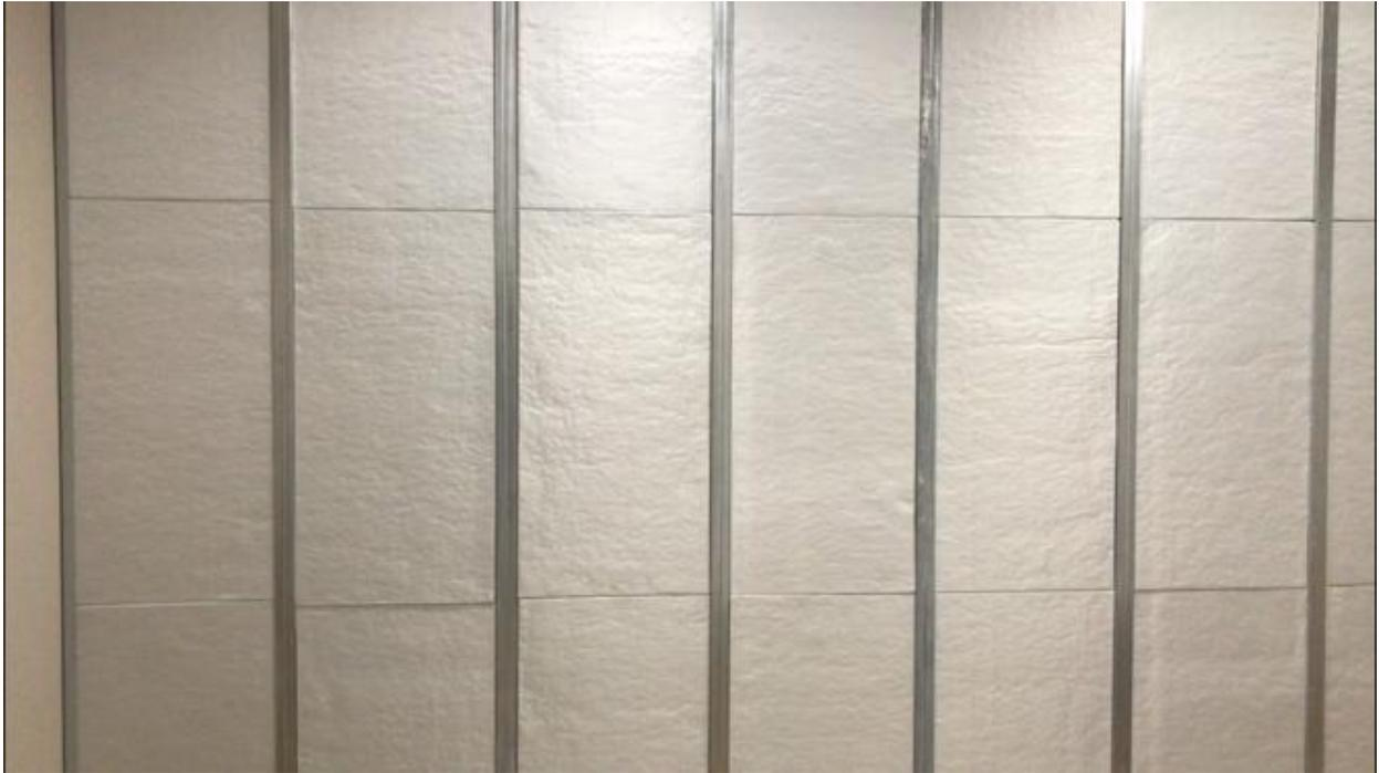
Atención: aplique una ligera presión entre panel y panel para eliminar cualquier hueco/junta. Las juntas pueden sellarse encintándolas con cinta adhesiva plateada tipo 'americano' TAPE-CORE.
