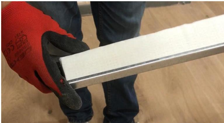
**Nota:** En caso de problemas de grosor (por ejemplo, nichos en balcones, atrios, etc.) en los que no es posible aplicar los 3,6 cm, es posible, si la pared es recta y la altura no supera los 3 metros aplicar la estructura sin el jinete, recuperando así 5 mm de espesor y llegando a un espesor total de aproximadamente 3 cm.
