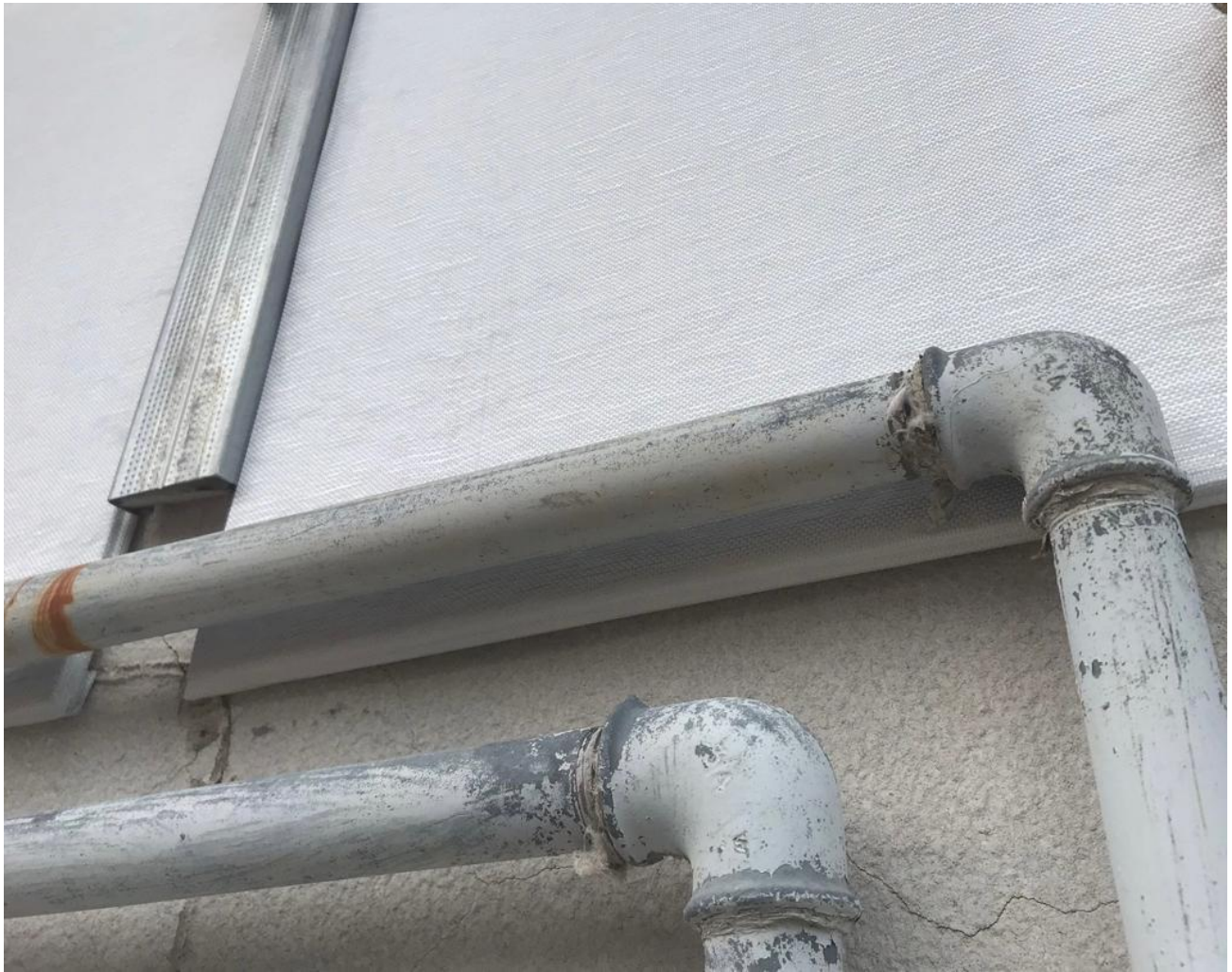
(CZ détail sous les tuyaux)
