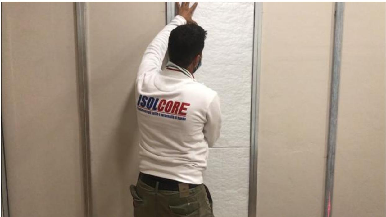
CZ-Paneele sind in verschiedenen Formaten erhältlich (siehe Datenblatt). Es liegt in der Verantwortung des Planers/Technikers oder des Installateurs, die Größe der Paneele zu überprüfen, um die Isolierung an der Wand oder an der Decke zu optimieren. CZ-Paneele können sowohl horizontal als auch vertikal verlegt werden, um 95-97% der Fläche (Wand oder Decke) zu isolieren. Falls die CZ-Paneele nicht die gesamte Fläche abdecken können, werden die kleinen
