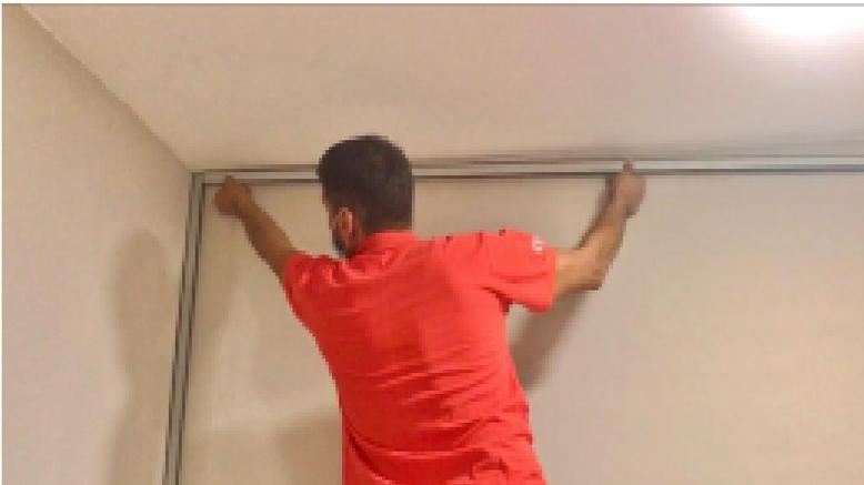
Befestigen Sie zunächst die obere Schiene an der Decke, mit den richtigen Befestigungen für den Träger, und legen Sie einen maximalen Abstand von 50 cm. Sobald die U-Schienen befestigt sind, werden die Klammern an der Wand angebracht, vorzugsweise im Abstand von 0,5 m, alle 60 cm horizontal und 90 cm vertikal;
