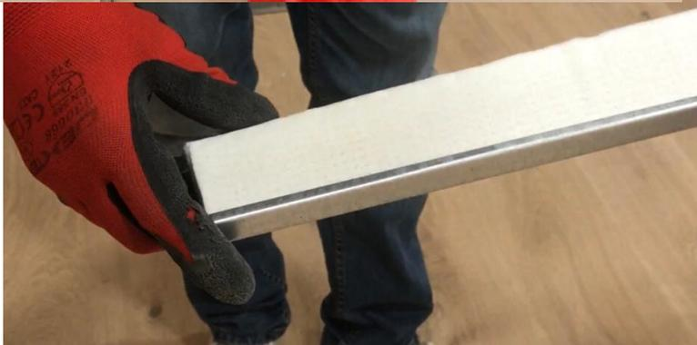
(Es wird empfohlen, einen Streifen NANOFELT-Isolierfilz unter dem Rahmen anzubringen, um die mögliche Wärmebrücke zu isolieren)
