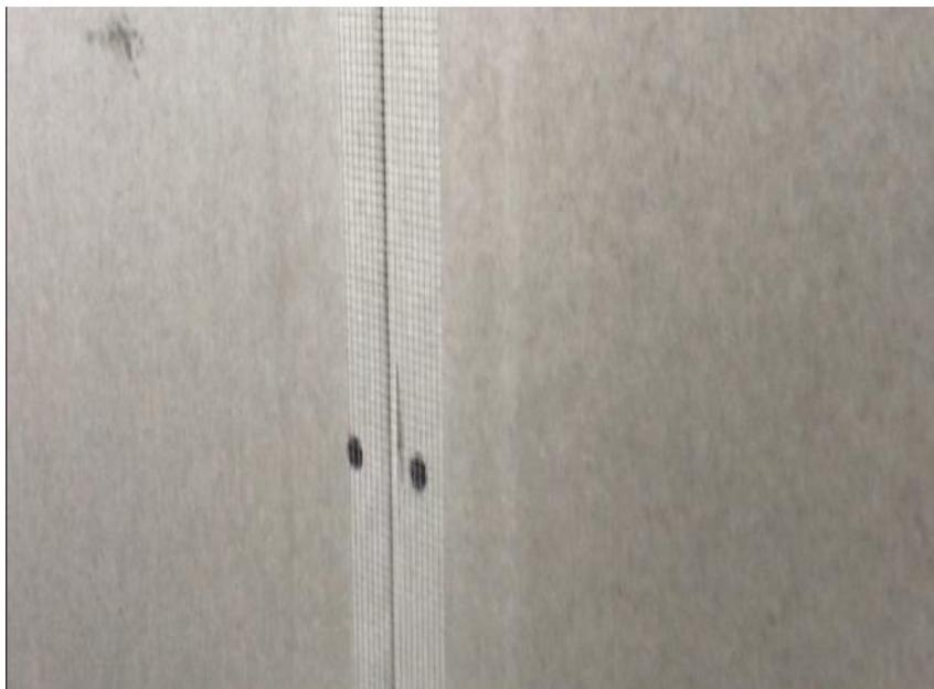
Nach Abschluss des Trocknungsvorgangs ist zu prüfen, ob entlang der Fuge keine Unebenheiten vorhanden sind; dazu mit dem Spachtel über die quer zur Achse liegende Fuge fahren und die Unebenheiten mit demselben Raketel oder mit einem feinkörnigen Schleifpapier entfernen.
