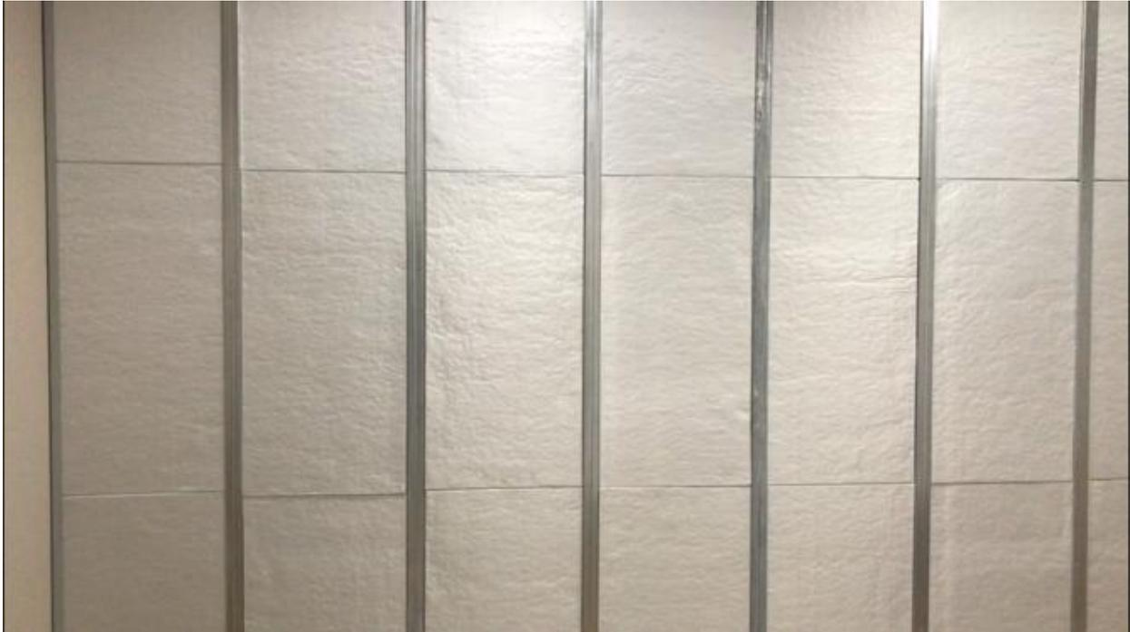
**Achtung:** Es wird empfohlen, einen leichten Druck zwischen Platte und Platte auszuüben, um Fugen zu vermeiden. Es ist möglich, die Fugen mit ISOL-TAPE Silberkleber, dem "amerikanischen" Kleber, abzudichten.
