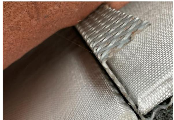
Gegebenenfalls ist das Dach mit einer selbstklebenden Schiefer- oder Flüssigabdichtung oder einer Flammabdichtung abzudichten. Anbringen der Konstruktion für ein mikrobelüftetes Dach. Dies kann mit speziellen, mikroperforierten Metallprofilen zur Aufnahme
