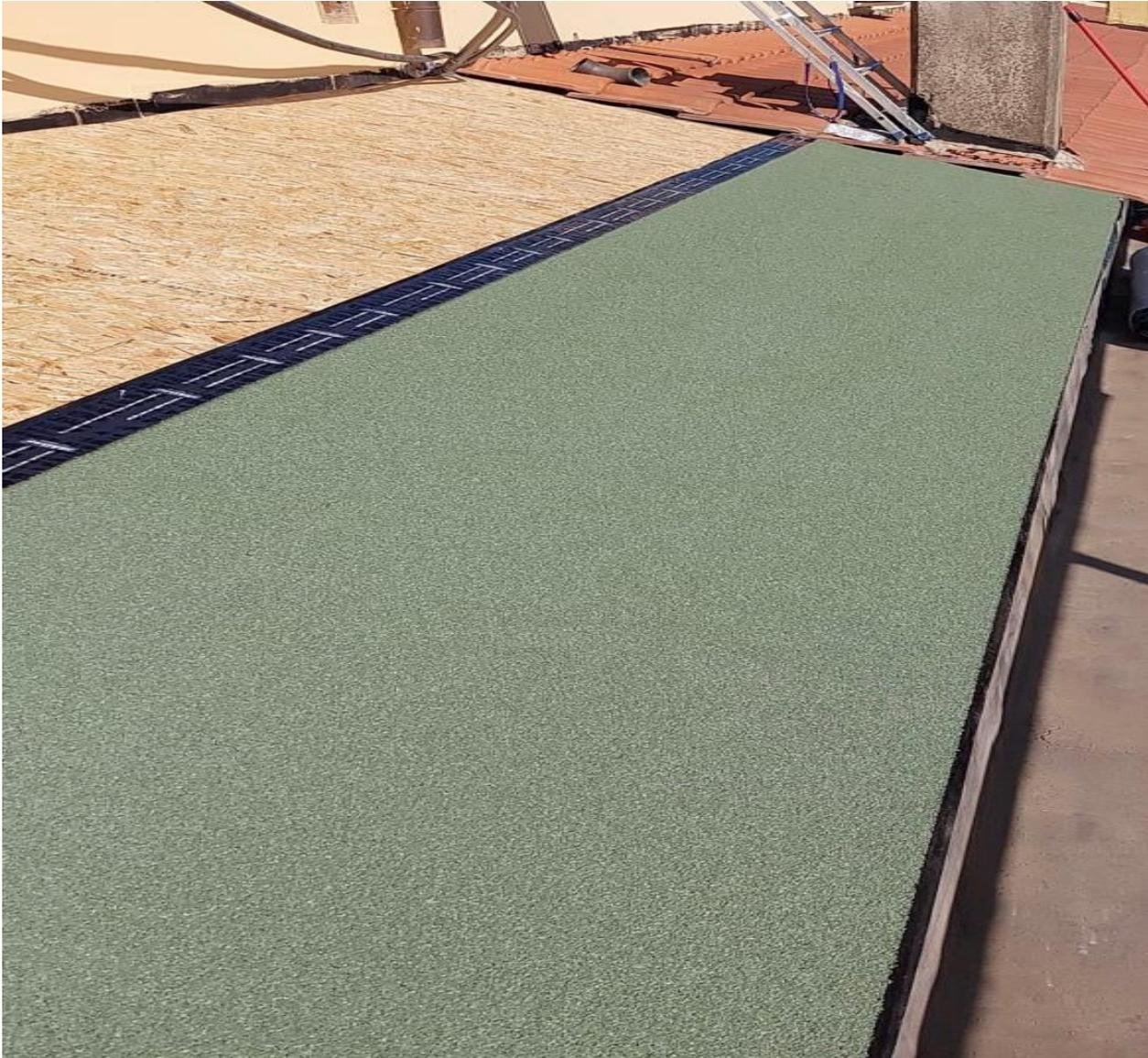
**Remarque :** si une grille de ventilation est utilisée parallèlement à la ligne d'égout et à cheval sur la pente, il est également possible de réaliser une toiture micro-ventilée.
