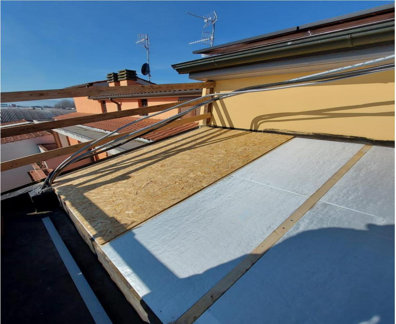
Sur le voligeage, on peut poser un revêtement d'étanchéité adhésif en forme d'ardoise (ou d'autres types, à condition qu'ils soient appropriés). Enfin, poser les tuiles.
