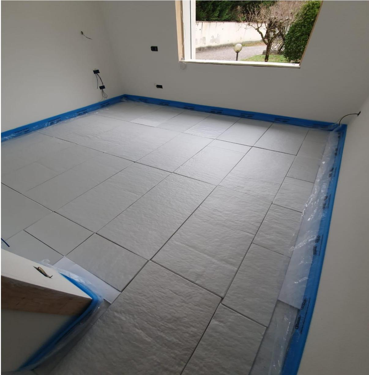
**Anmerkung:** Es wird empfohlen, die Fugen der CZ-Platten und den Rand des Bodenbelags mit einem Aluminium- und Bitumenklebeband abzukleben.
