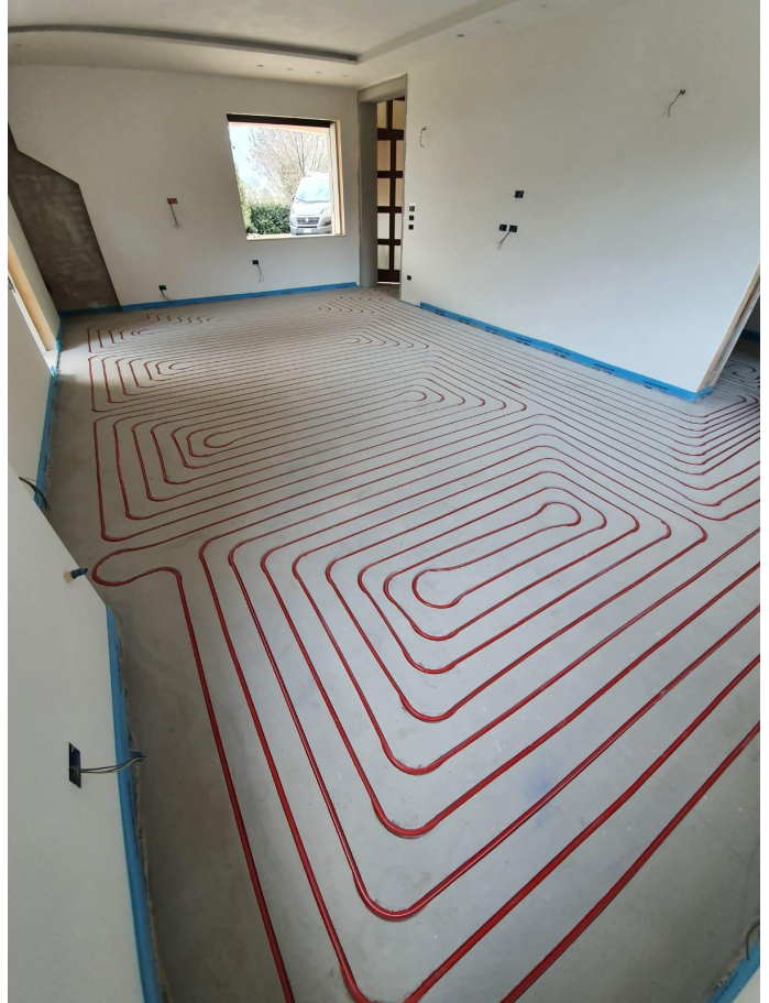
Pose de tuyaux
